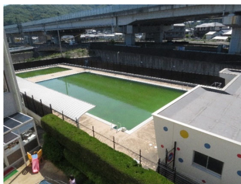
隣接する海田東小学校プール
