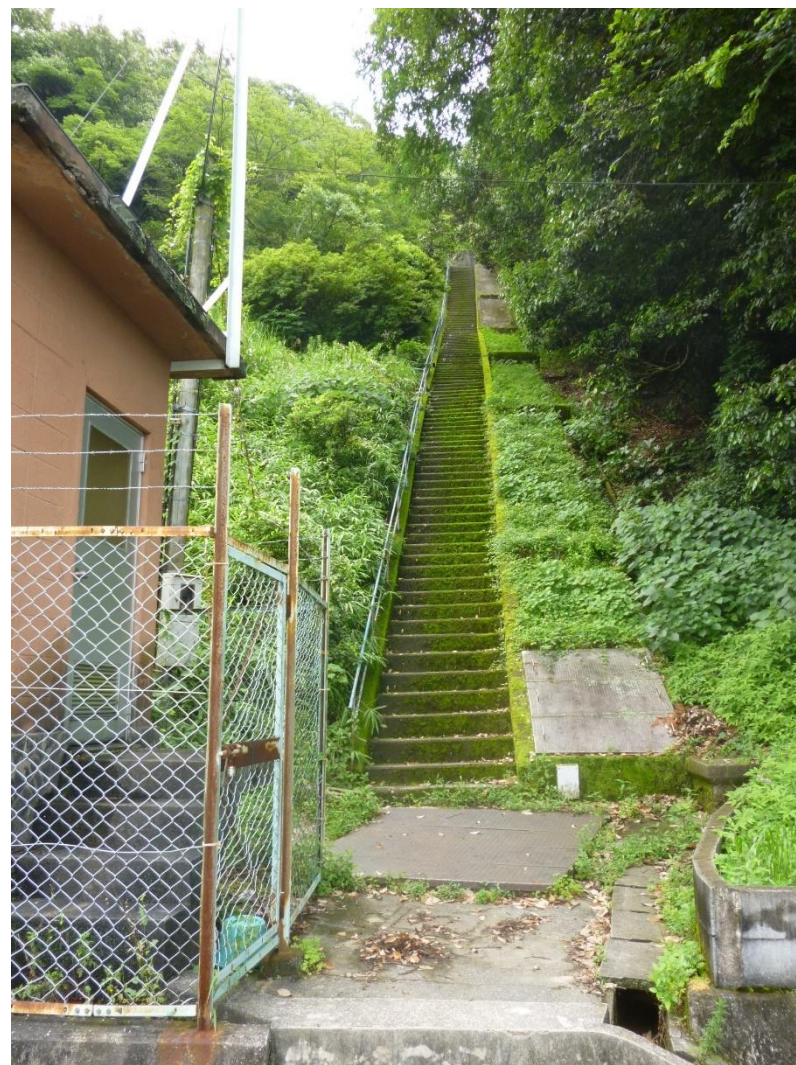
国信配水池入口
