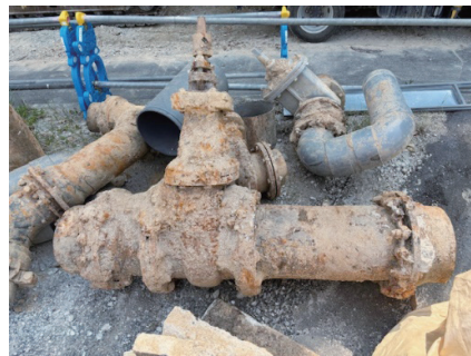
● 老朽水道管（昭和47年）撤去 ●
