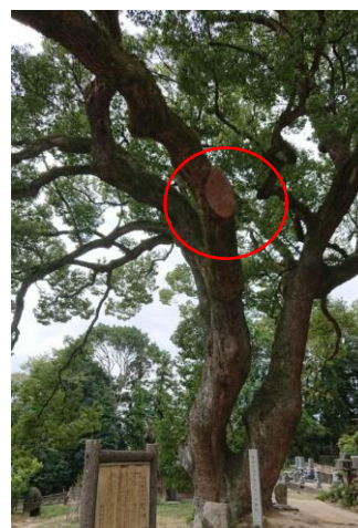
切除後の断面 (2023. 10. 3)
