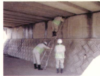
定期点検 (下部工)
