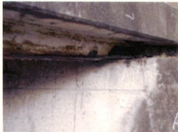
鋼桁の腐食
