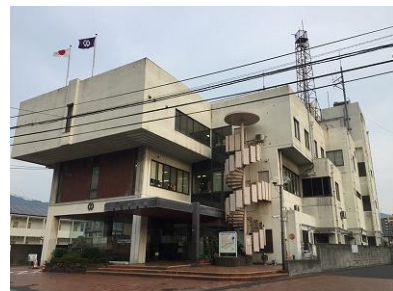
海田町役場（現庁舎）
